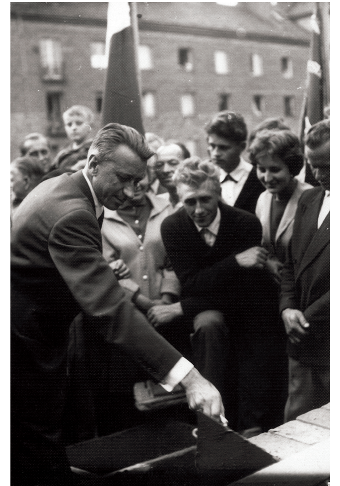
Wmurowanie aktu erekcyjnego - 19 lipca 1962
