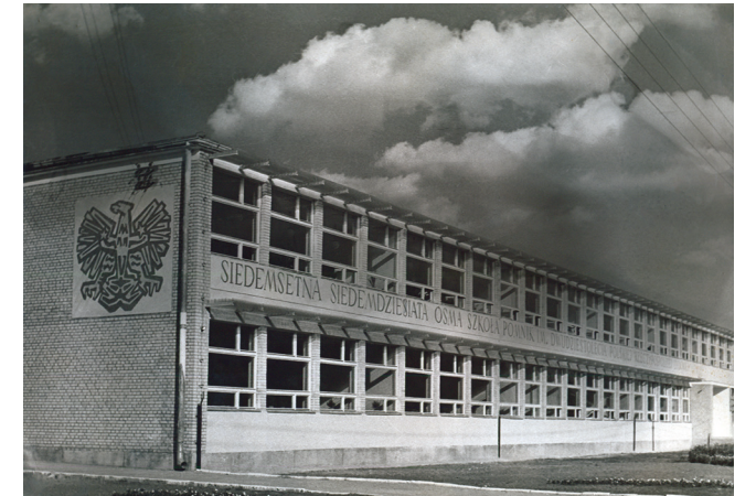
Nowy budynek szkoły - ul. Długa 89/91
